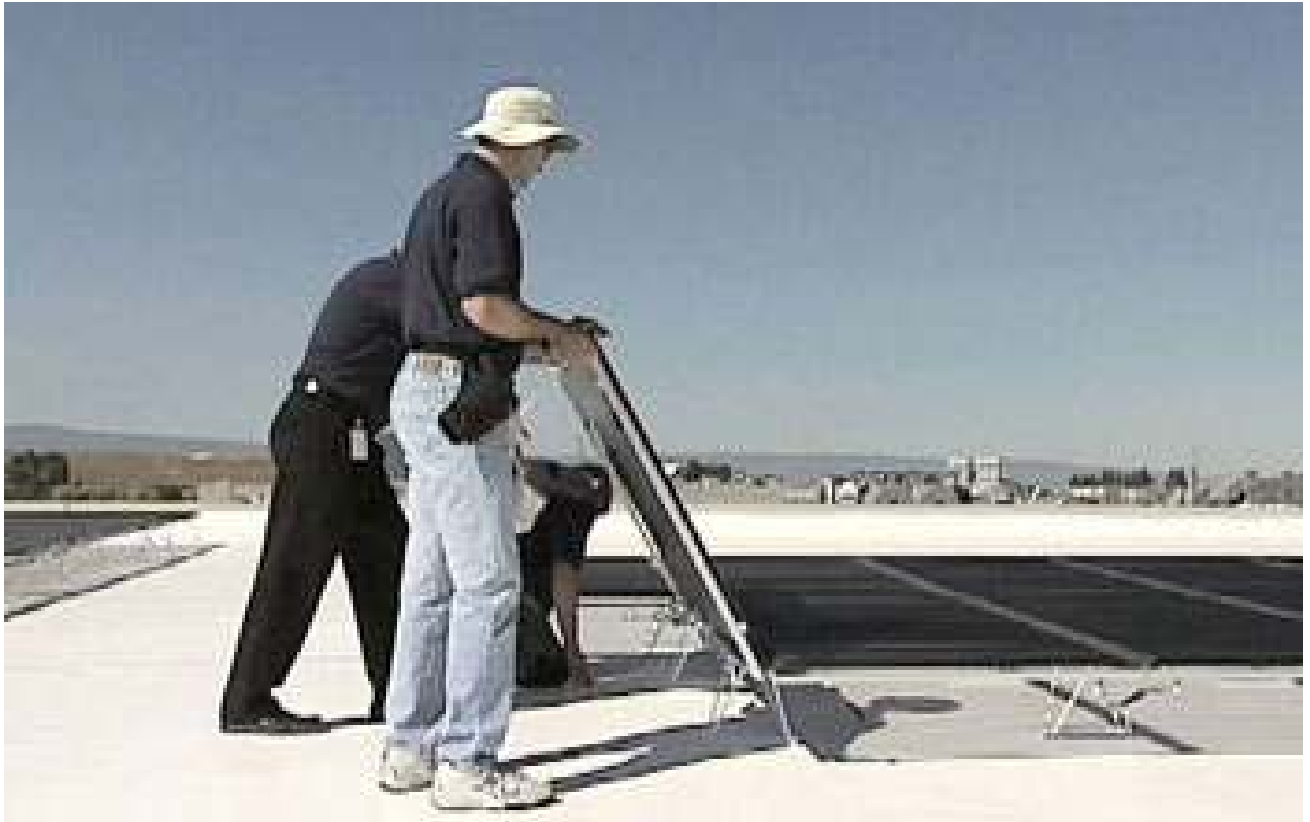
Posizionamento, collegamento dei connettori a corrente continua e messa a terra.
