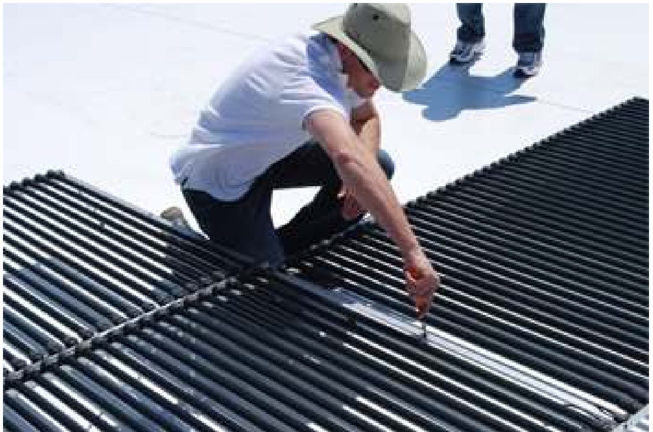
Installazione dei fissaggi laterali
